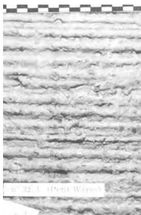
Figure 2.11 : Texture de surface après passage d'un peigne métallique, [3.]
