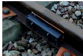
Exemples d'absorbeurs sur rail (Corus et Socitec)
